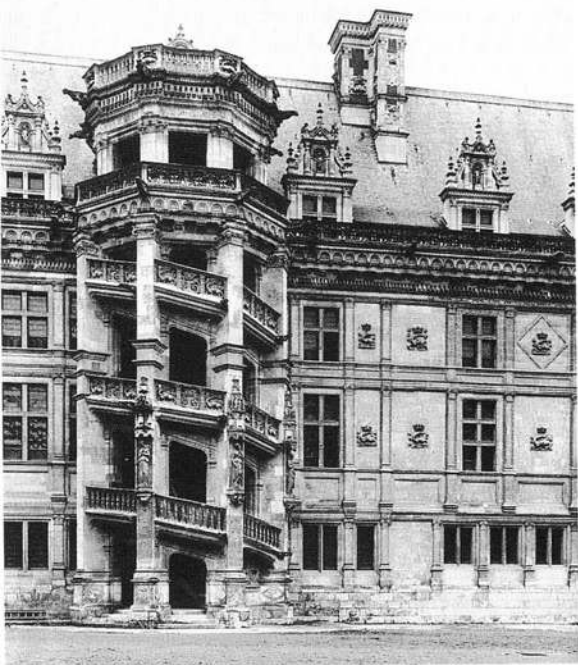
Выравнивание оконных проемов
